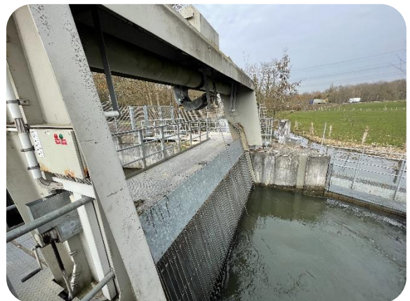
Abbildung 2-Rechenreinigungsanlage
